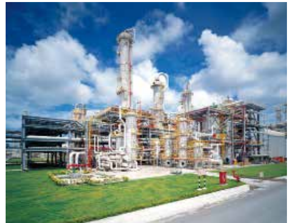
石化工廠 Petrochemical plant
