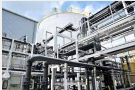
化學工程 Chemical engineering
