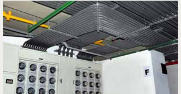
電導管工程 Electrical engineering
