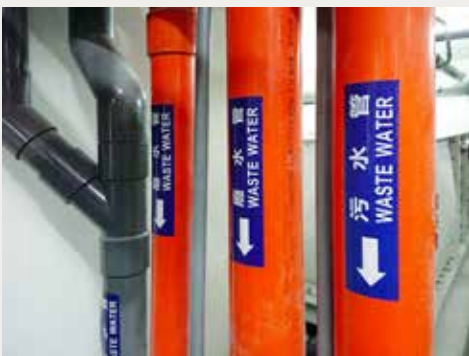
下水道工程 Sewer Engineering
